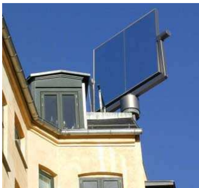
Heliostat : optimisation de la lumière naturelle
