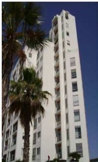
Figure 4 - Un bâtiment passif (Torre Verde) naturellement ventilé à Lisbonne
