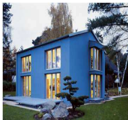
Figure 2 - Une Passivhaus en Allemagne
